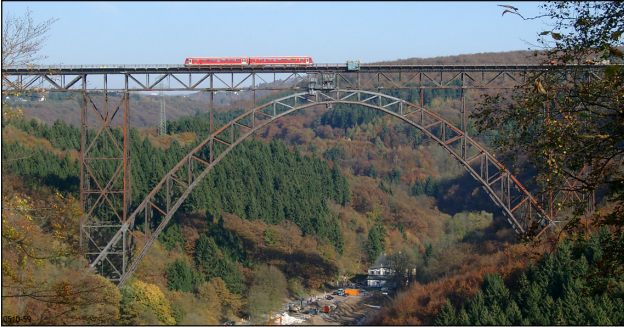
Abb. o.: Ein Triebwagen der Baureihe 628 auf der Müngstener Brücke. Im Bereich des Scheitels des Schub Bogens befindet sich ein Baugerüst, da zum Zeitpunkt der Aufnahme kleinere Inspektionsarbeiten ausgeführt wurden. Foto: D. Düppel 29.10.2005
