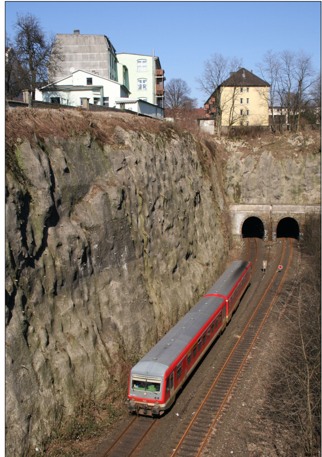
Abb. o.: Ein Zug Richtung Solingen verläßt den Westlichen Rauenenthaler Tunnel und befindet sich im kurzen aber imposanten Einschnitt am südlichen Tunnelportal.
