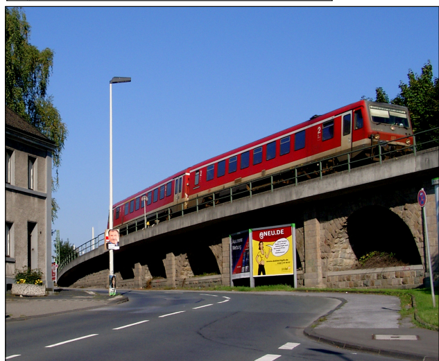
Abb. o.: Das Gleis Richtung Remscheid wird schon kurz nach dem Verlassen des Ohligser Bahnhofes auf das Überwerfungsbauwerk geführt, um die Verbindungskurve zu überqueren. Foto: Düppel
